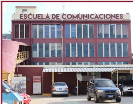
Edificio Federico García Lorca
