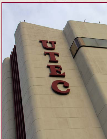
Edificio Los Fundadores
