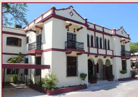
Edificio Dr. José Adolfo Araujo Romagoza
